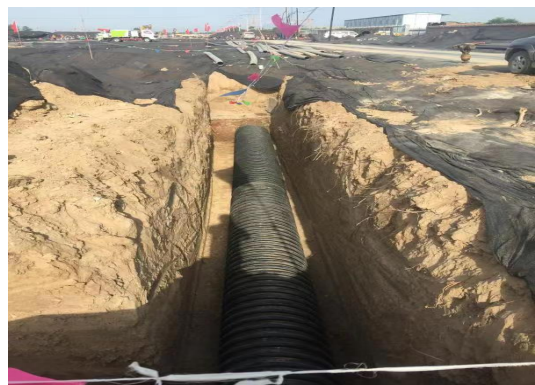
图10 污水管道建设
