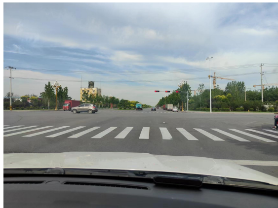
图 14 项目起点交叉路口
